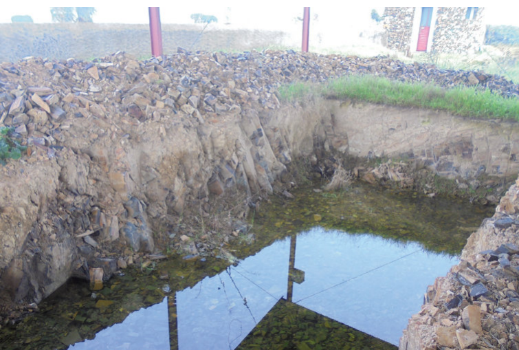
Estanque en construcción en Herdade das Cebolas, Campinho, Portugal. (Enero, 2018). Joana Paulo
